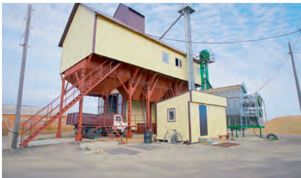
Зерноочистительный комплекс в ОАО «Чистоозёрный плодопитомник»
